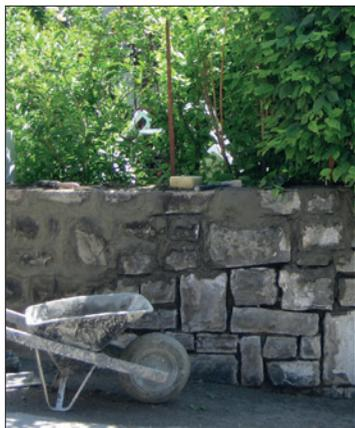
Les joints de ce mur en pierres ont été refaits avec du ciment rigide et hermétique. Deux ans après les travaux, le mur est déjà fissuré, car le ciment n'a pas suivi les variations du mur. Ce ciment presque inaltérable mettra des années à accueillir une biodiversité intéressante et demeurera moins propice qu'un mortier plus rugueux et tendre. Les fentes formées grâce aux pierres apparentes accueillent quelques mousses et plantes à fleurs.
